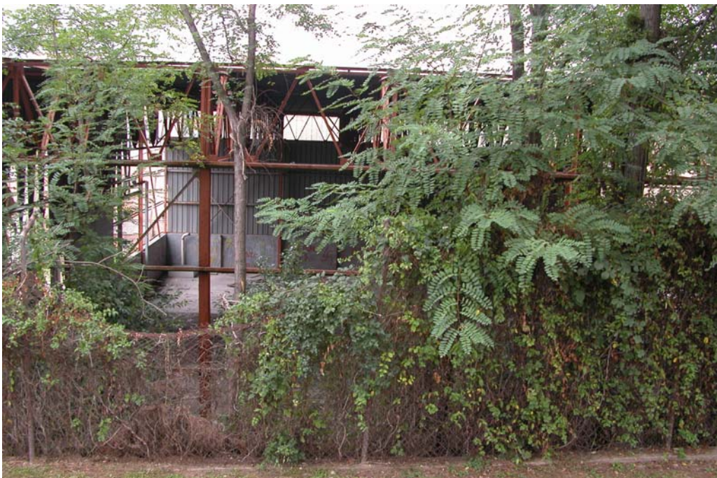
Nau industrial en runes i vegetació abandonada amb espècies invasores d'ambients degradats.
