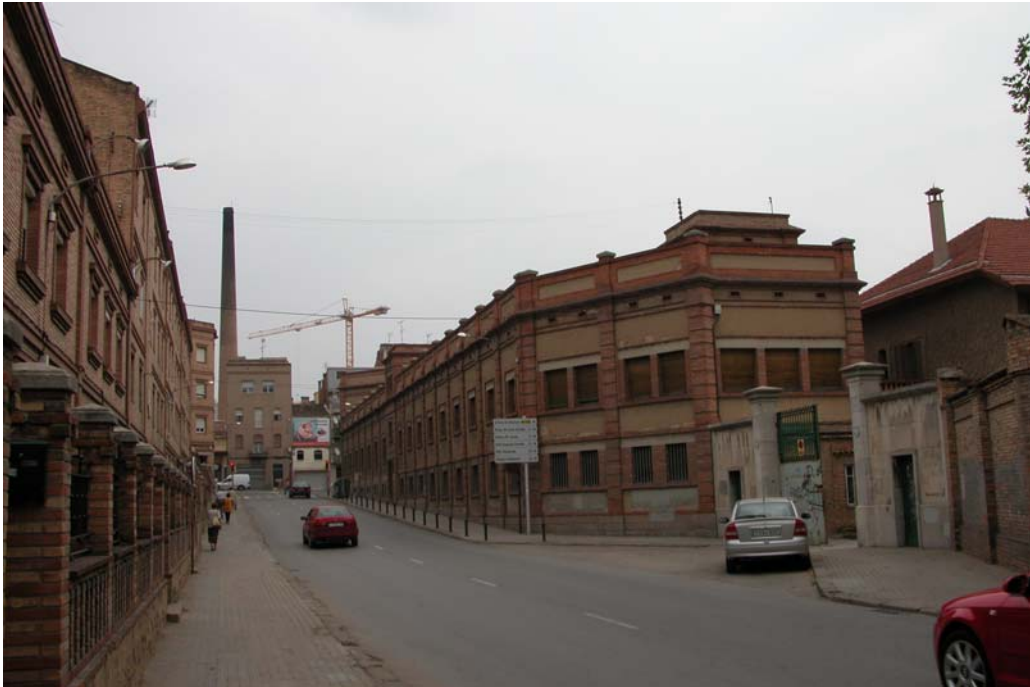
Accés principal recinte industrial pel Carrer Bertran Serra
