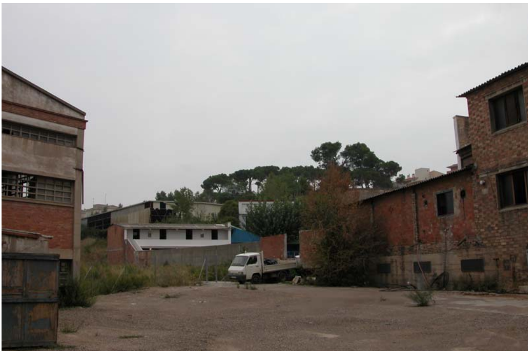
Interior del recinte amb edificis en desús que està previst el seu enderrocament Al fons destaca la pineda del Parc de Sant Ignasi
